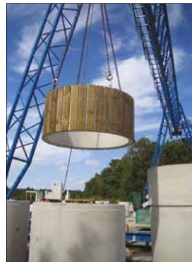
In de betonfabriek worden de beide gedeelten van de silo al samengevoegd.
