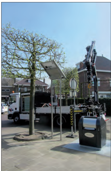
Service aan Solar perscontainer.
